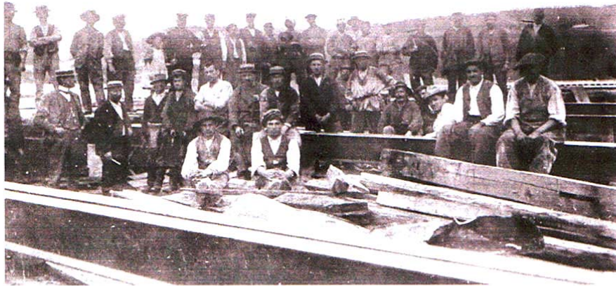
Ces travaux durent être menés par une équipe solide et peu sensible au vertige. Il se peut qu'il y ait eu de nombreux italiens parmi l'équipe de construction. Mise en place de poutres en acier Sigwart.
